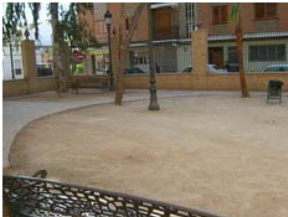
Imagen donde se aprecia el muro abierto del Jardín.
