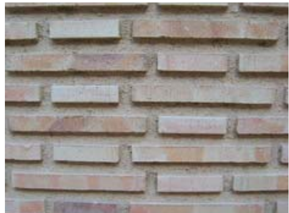
Imagen donde se observa claramente el aparejo flamenco.
